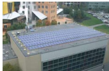
Photo: Ruth Davis, MIT Facilities
